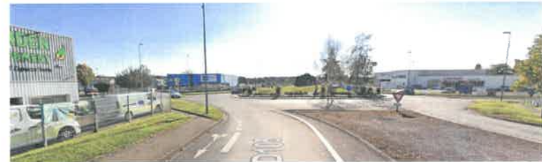
Figure 4 - Entrée sud de Mainvilliers - D105
