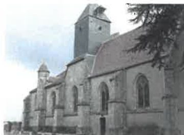
Figure 11 - Eglise de Mainvilliers
