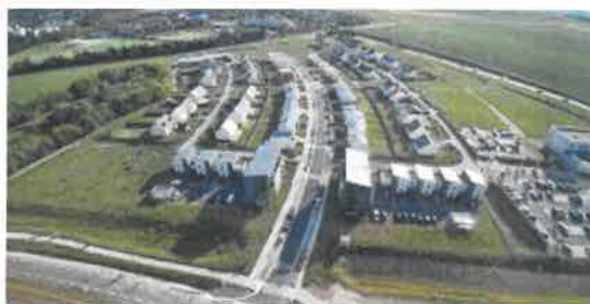
Figure 14 : Quartier de Boisville à proximité de la RN1154
