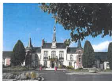
Figure 10 - Mairie de Mainvilliers
